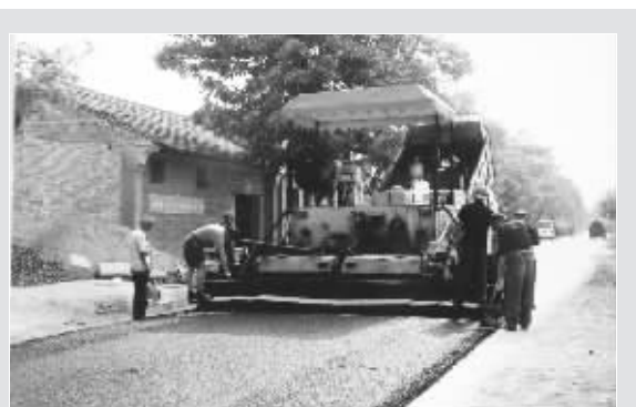
通村路施工现场。
